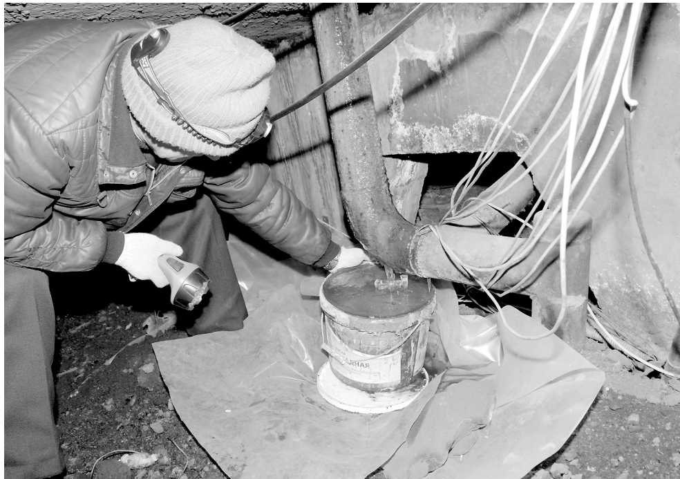
Чердак дома по улице Дачной, 23/3. Очередное ведро «черДАЧНОЙ» воды.
